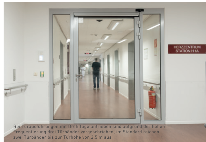
Reduktion und Perfektion liegen nahe beieinander. Die sehr niedrige Bauhöhe des Antriebs ermöglicht eine nahezu unsichtbare Integration in das Türelement
