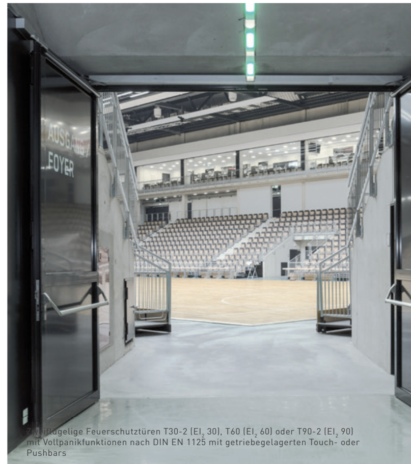
Zweiflügelige Feuerschutztüren T30-2 (EI 2 30), T60 (EI 2 60) oder T90-2 (EI 2 90) mit Vollpanikfunktionen nach DIN EN 1125 mit getriebegelagerten Touch- oder Pushbars
